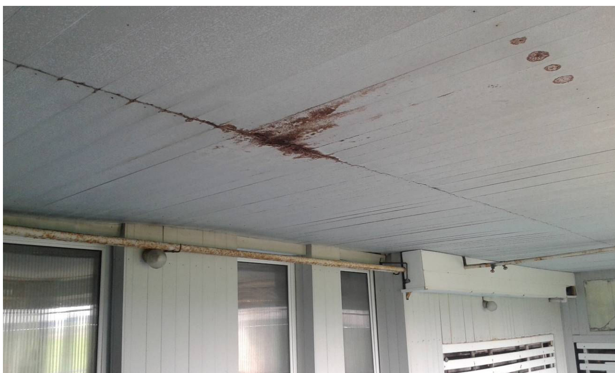
ZDJĘCIE NR 1.5. SKORDONOWANA OKŁADZINA SUFITU (WYKONANA Z PŁYT STALOWYCH) ORAZ RURY CO W HALI BASENU
