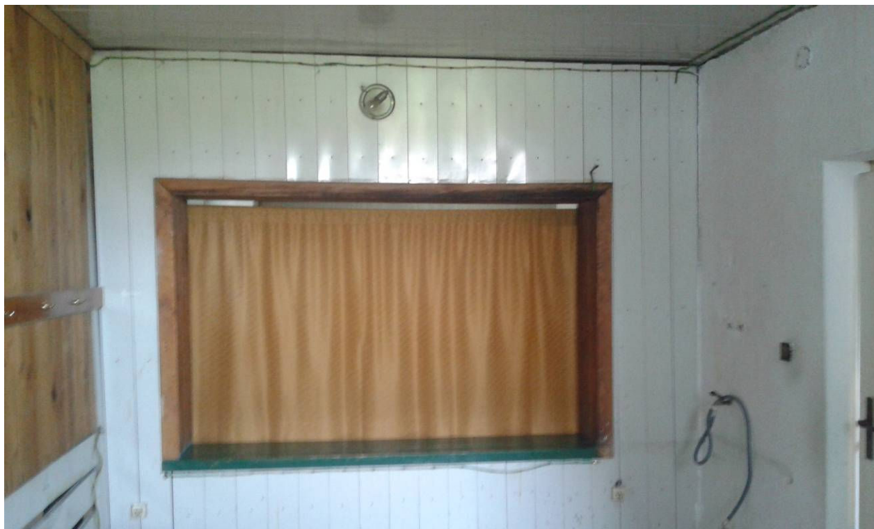
ZDJĘCIE NR 5.1. PANELE STALOWE ORAZ BOAZERIA DO DEMONTAŻU, WNĘKA OKIENNA PRZEZNACZONA DO ZAMUROWANIA
