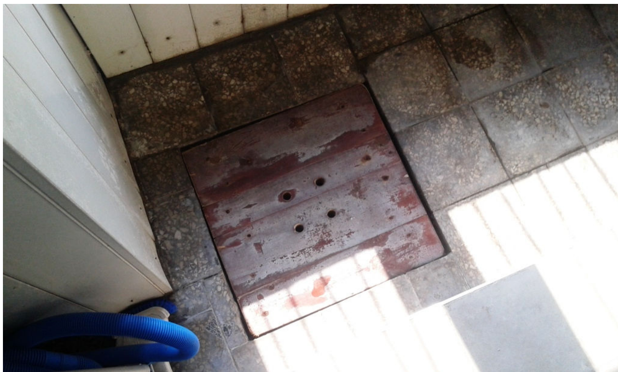
ZDJĘCIE NR 1.2. STUDZIENKA REWIZYJNA – PRZEZNACZONA DO WYMIANY
