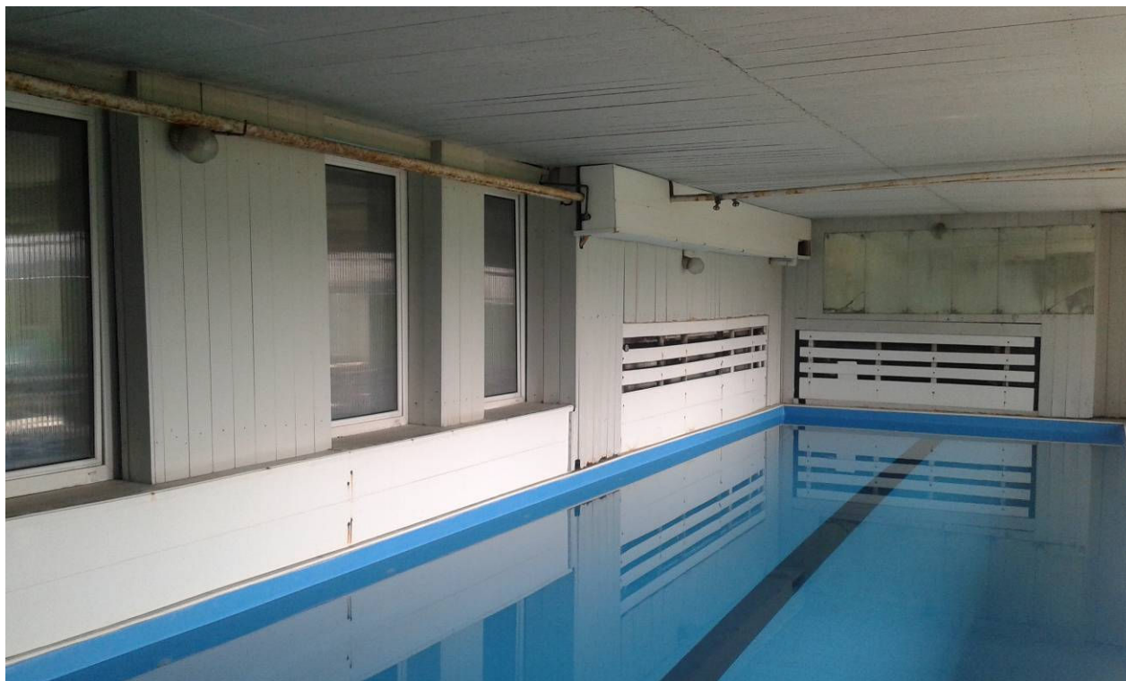
ZDJĘCIE NR 1.4. HALA NIECKI - OKNA WEWNĘTRZNE PRZEZNACZONE DO DEMONTAŻU Z PARAPETEM, OKŁADZINA ŚCIENNA Z PŁYT STALOWYCH, OBUDOWA RUR CO I GRZEJNIKÓW ORAZ LUSTRA DO DEMONTAŻU
