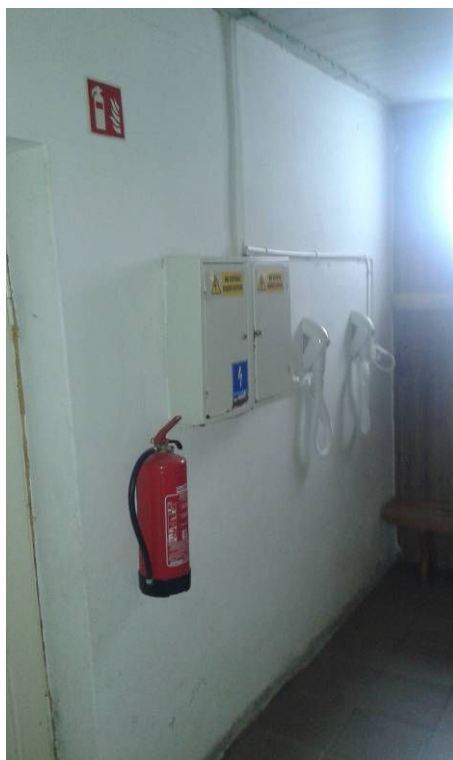
ZDJĘCIE NR 5.2. TABLICA ROZDZIELCZA DO PRZENIESIENIA ORAZ SUSZARKI BASENOWE DO DEMONTAŻU
