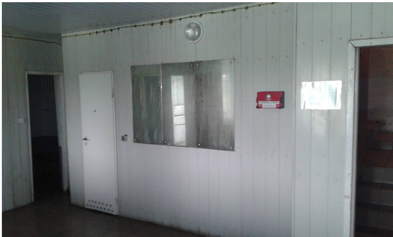
ZDJĘCIE NR 2.1. OKŁADZINA ŚCIENNA Z PŁYT Z BLACHY STALOWEJ, LUSTRA, DRZWI ORAZ OKŁADZINA SUFITU PRZEZNACZONE DO DEMONTAŻU.
