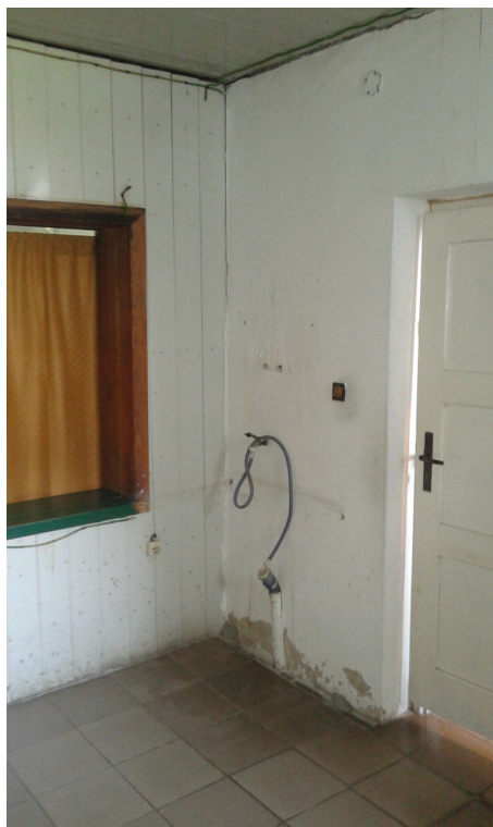
ZDJĘCIE NR 5.3. PŁYTKI PODŁOGOWE ORAZ CZERPAK WODY DO WYMIANY
